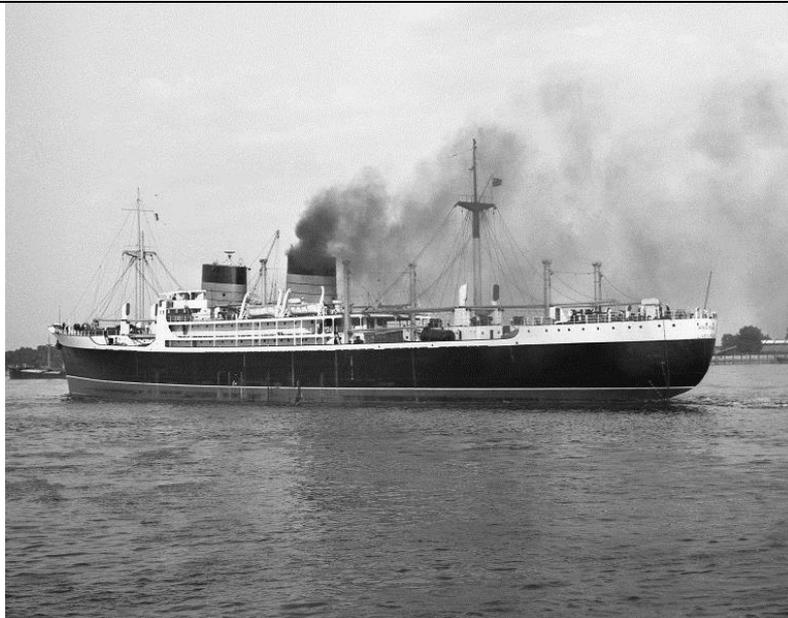
圖 3 英國造蒸汽渦輪引擎推進『復中輪』
